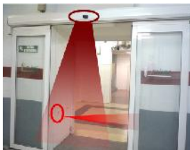
Exemple de detector i zona que detecta
